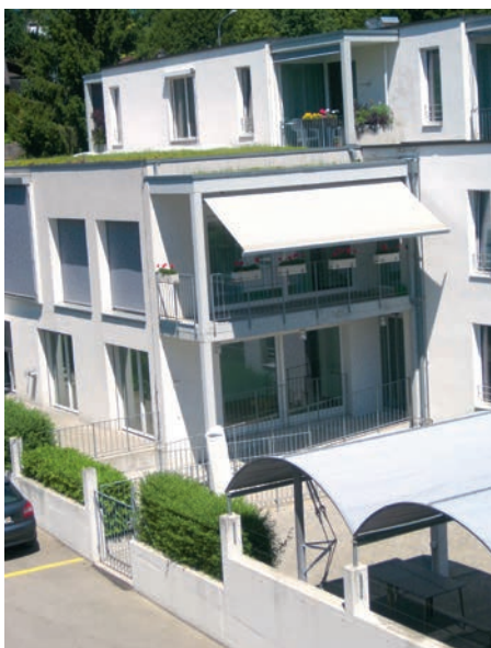
Blick von der Brücke nach Aegerten hinunter zu den Räumlichkeiten der entstehenden Arztpraxis im Untergeschoss.
