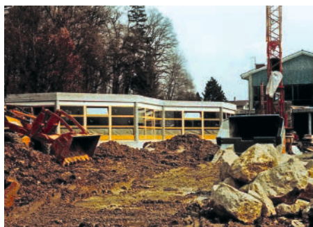
Neubau der Bibliothek Höfli
