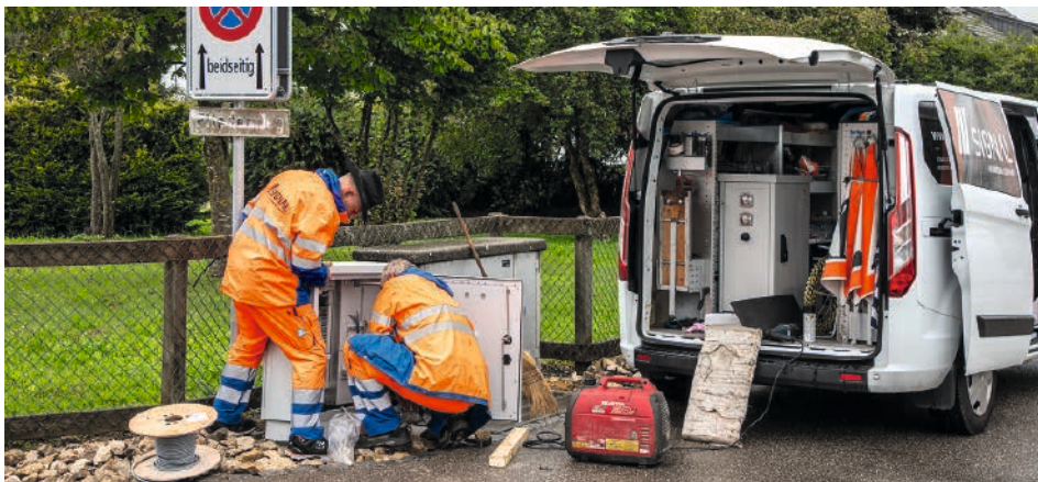
Das Team der Signal AG setzt den Steuerungskasten.
