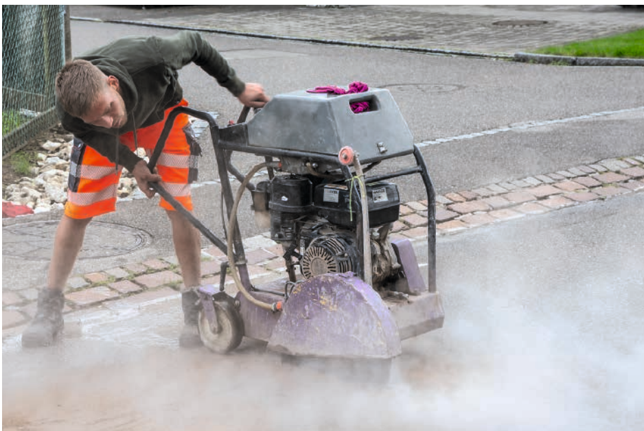
Julian Piseru, Stettler AG Biel Studen, fräst den Strassenbelag auf.
